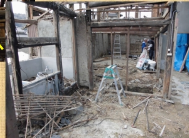
柱と一部の壁だけの状態へ
